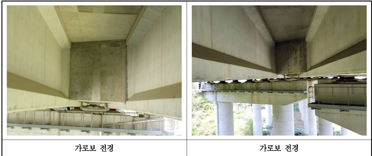
【사진 40.3.6】 가로보 전경
