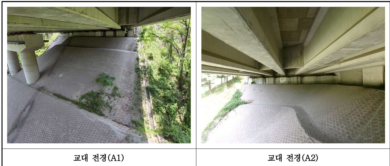
【사진 40.3.8】 교대 전경
