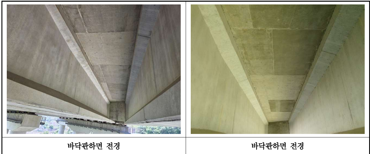
【사진 40.3.2】 바닥판하면 전경
