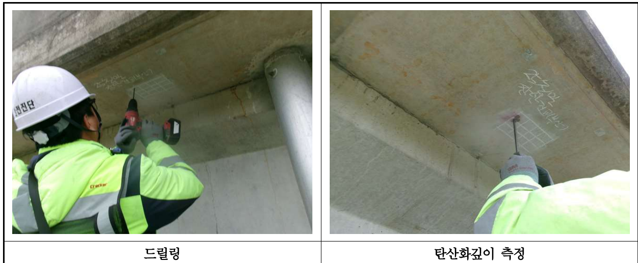
【사진 40.4.3】 탄산화 깊이 측정 현장사진
