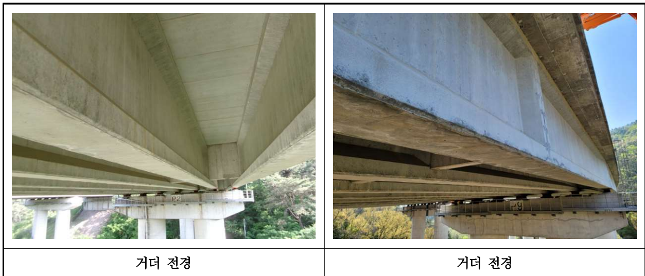
【사진 40.3.4】 거더 전경
