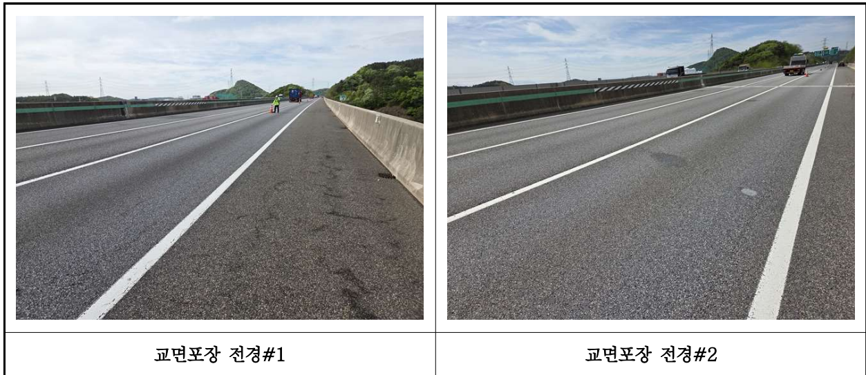
【사진 40.3.20】 교면포장 전경
