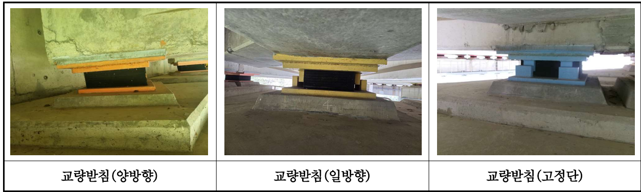
【사진 40.3.13】 교량받침 전경
