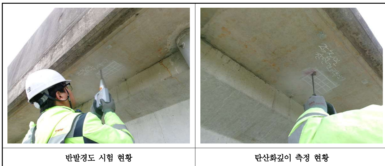
【사진 40.4.1】 콘크리트 내구성조사 현황
