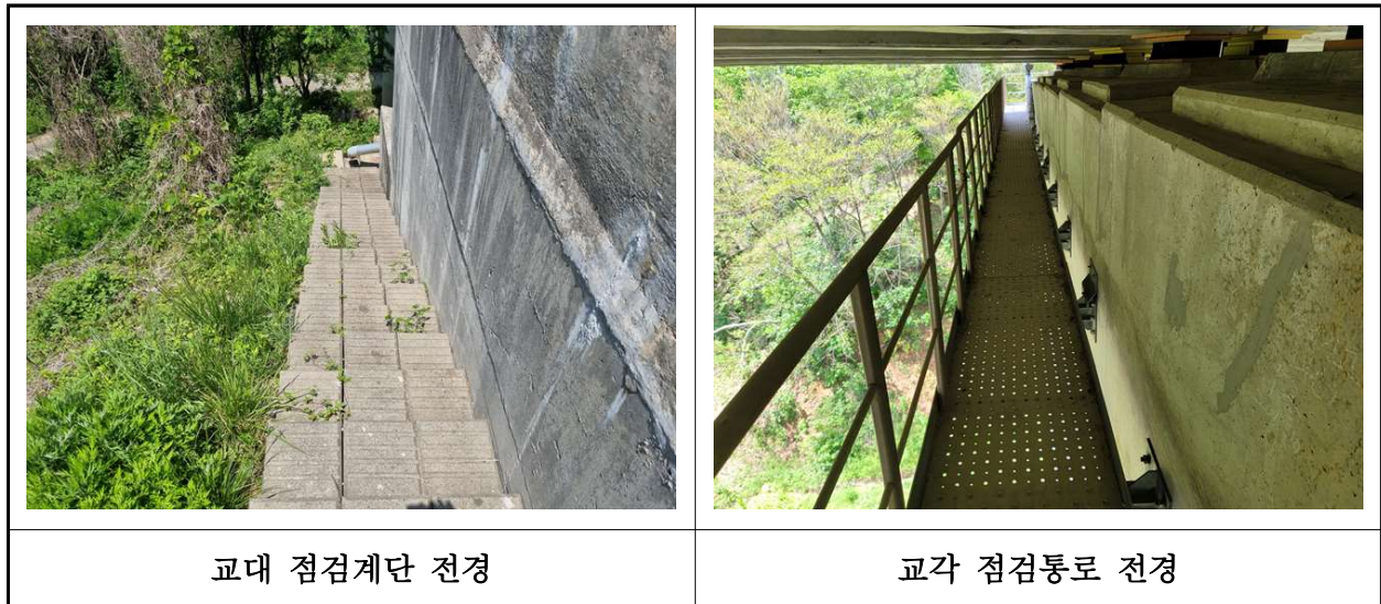
【사진 40.3.26】 교량 점검시설 전경
