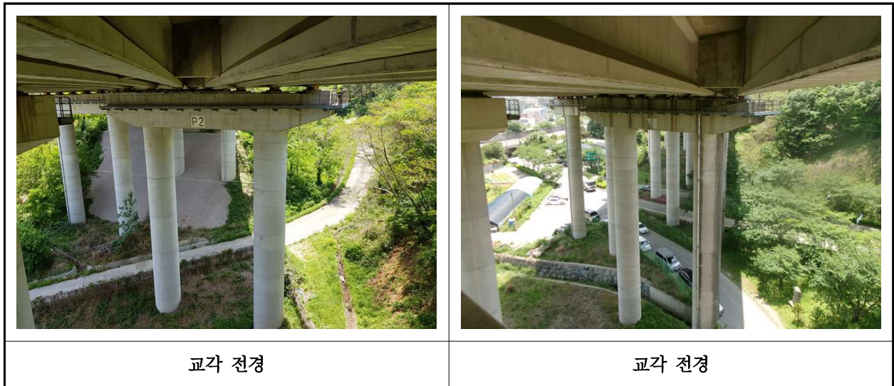
【사진 40.3.10】 교각 전경
