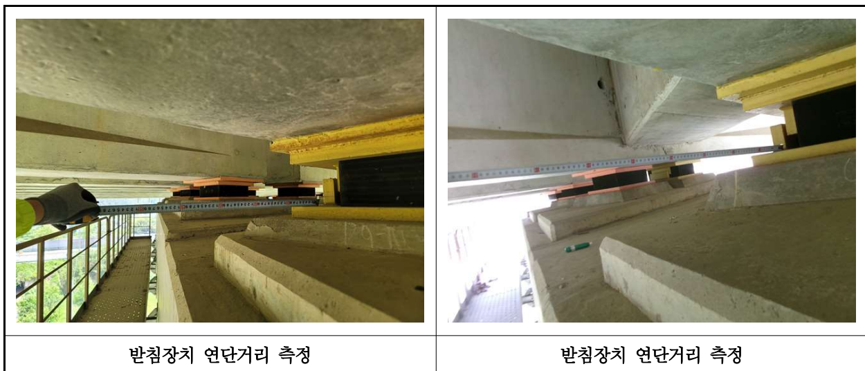
【사진 40.3.15】 교량받침장치 연단거리측정
